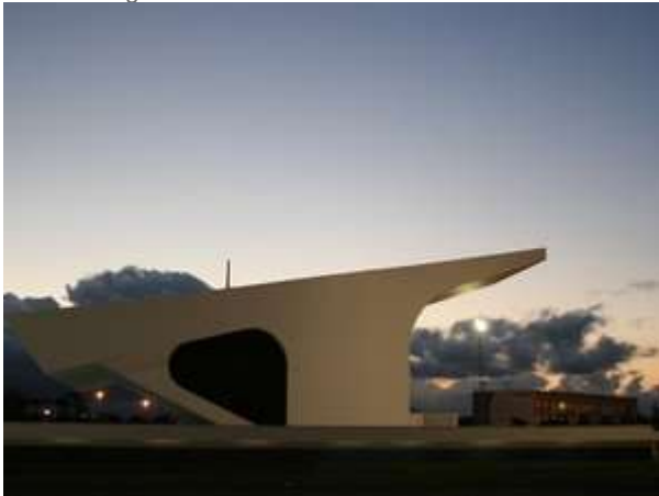
Centro de Convenções da UENF
